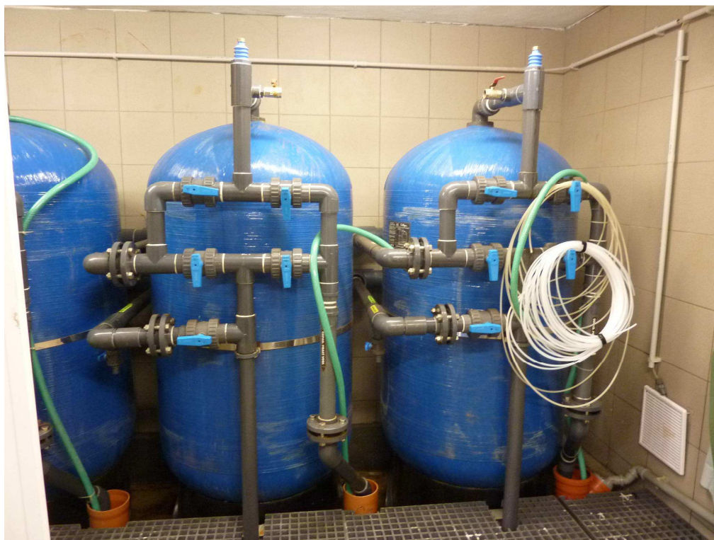
Prameniště Ostrov – filtrace, odstranění arsenu
